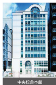
中央校舎本館
